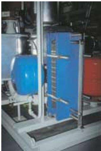
Теплообменники от FUNKE состоят из пакета гофрированных теплообменных пластин. Пластины оснащены уплотнениями, которыми уплотняются и разделяются друг от друга каналы протекания.
